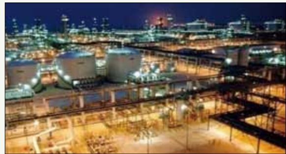
RAS LAFFAN PROJECT PHASE 6 & 7 Onshore LNG Plant
